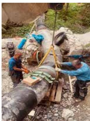
Das im März 2022 gebrochene Druckrohr des Kraftwerkes in der Melang wurde wieder repariert, das Kraftwerk konnte so Ende Juni wieder in Betrieb genommen werden. Eine neuerliche Reparatur und der endgültige Abschluss der Arbeiten werden im Herbst 2022 erledigt.
